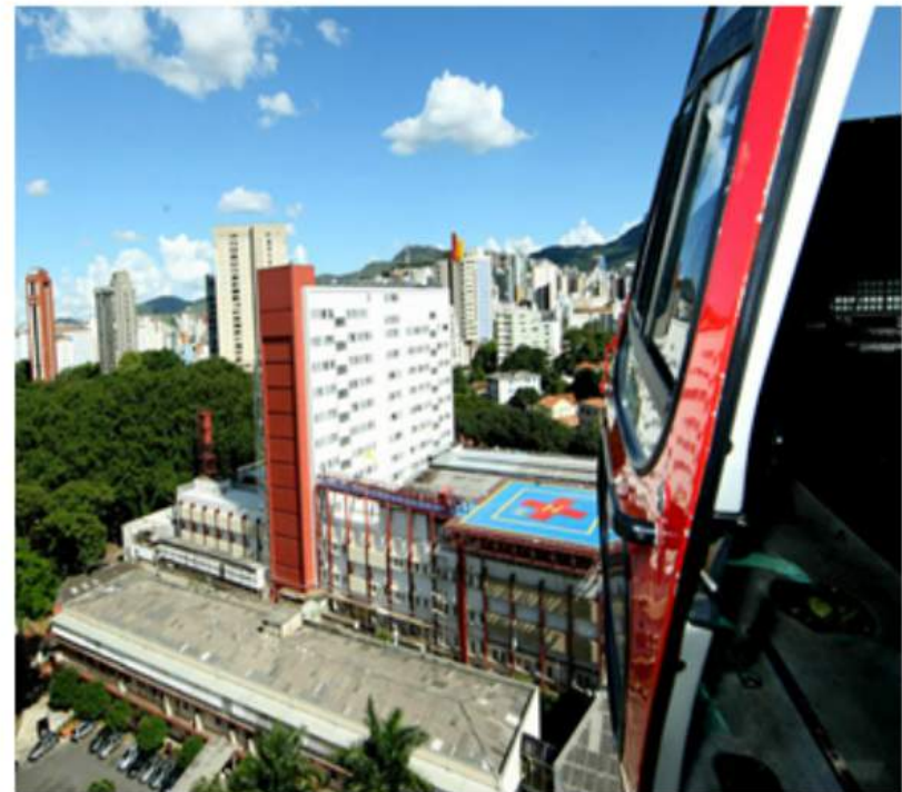
Vista aérea hospital João XXIII
