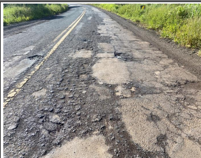
Foto 04 - Trincas generalizadas
